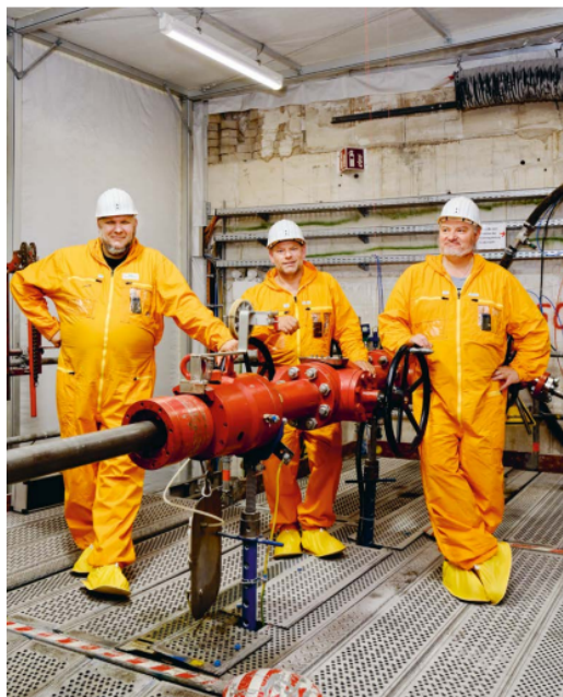
Drei Mann am Bohrerät: Olaf Börner (links) koordiniert zusammen mit Bauleiter Dennis Dillge (Mitte) die Erkundungsarbeiten unter Tage. Ralf Speck ist für den Strahlenschutz verantwortlich
